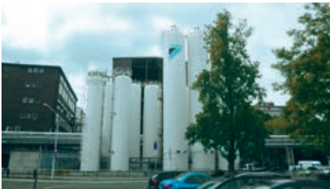
03 | Produktionsanlage für Hydrofluorkohlenwasserstoff, Daikin.
