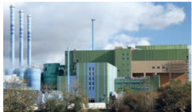
02 | Ersatzbrennstoff-Anlage, Infraserb Höchst
