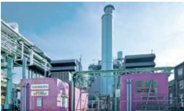
01 | Gasturbinenanlage, Infraserb Höchst
