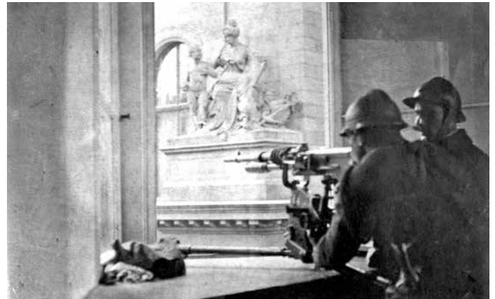
Französischer MG-Posten in der schon fertig gestellten Brücke des Verwaltungsgebäudes während der Besetzung des Werkes im Jahr 1923.
