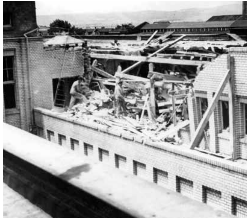
Im 2. Weltkrieg wurde der Hörsaal am 29. Juni 1940 durch Sprengbomben zerstört.
