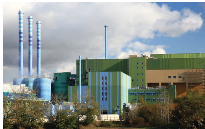
Ersatzbrennstoff-Anlage, Infraser Höchst
