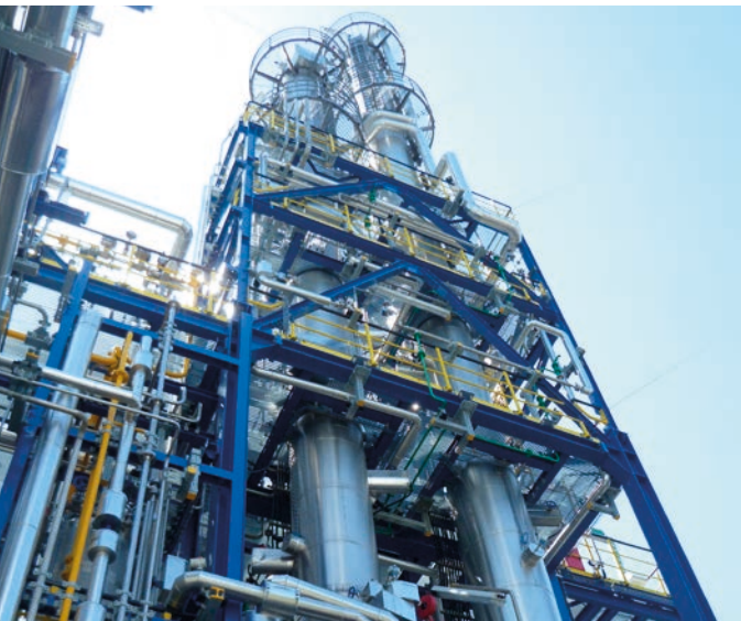
Produktionsanlage für Dimethylether, Grillo
