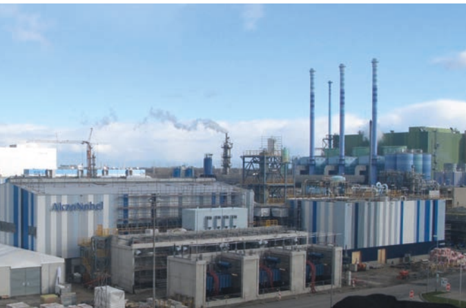
Erweiterung der Chlor-Alkali-Produktionsanlage, AkzoNobel
