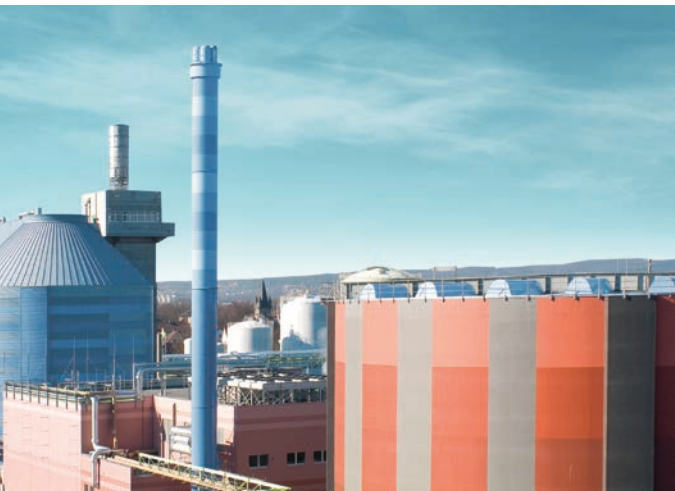
Biogasanlage, Infracore Höchst
