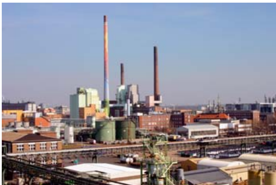
Bild 1: 167 m ragt der bunte Kamin des Heizkraftwerkes im Industriepark Höchst empor. Es erzeugt Wärme und Strom für die im Industriepark angesiedelten Unternehmen. Vorrangiges Ziel des Betreibers ist eine optimale Energieversorgung der Kunden. Letzte große Investition war der Einbau einer 40-Megawatt-Gasturbine in das Kraftwerk.
