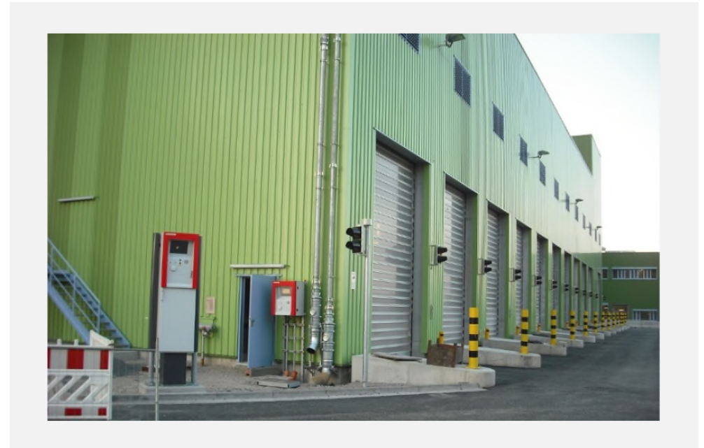
Bild 6: Anlieferhalle der EBS-Anlage (Gebäude H318).
