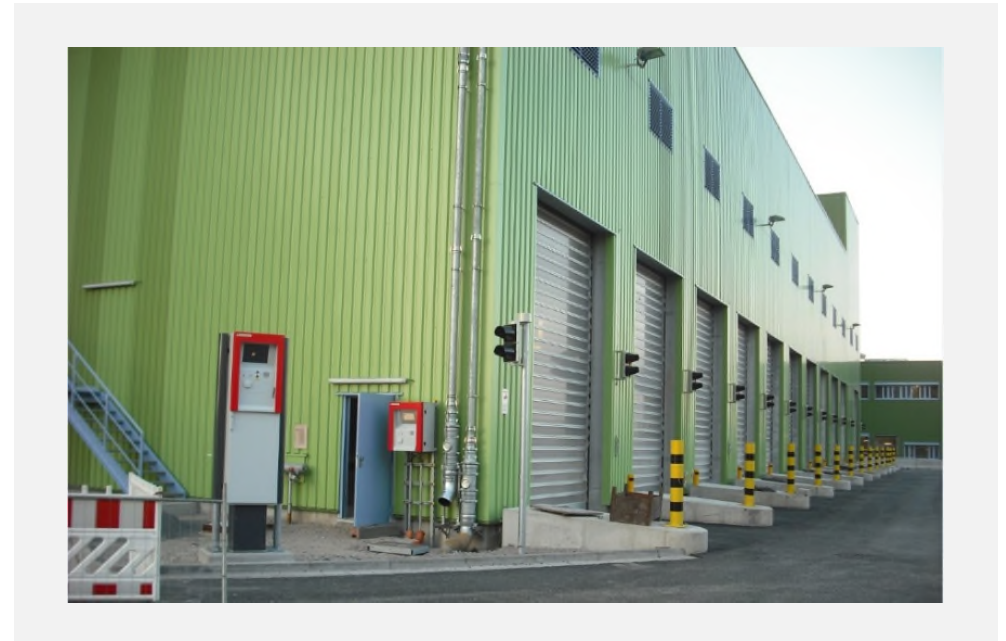
Bild 6: Anlieferhalle der EBS-Anlage (Gebäude H318).
