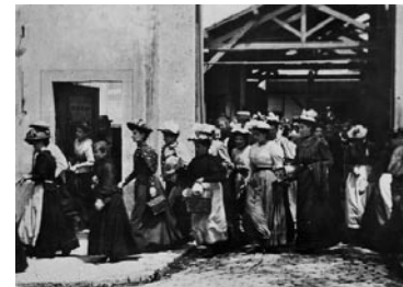
Lumière-Film: Arbeiter gehen aus der Fabrik nach Hause
